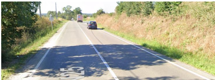
Figure 35: Photo de la N25 vers Grez-Doiceau (Google Maps)
